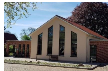
Neues Gemeindehaus in Ahlden
